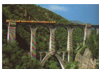
Le viaduc du petit train jaune.
